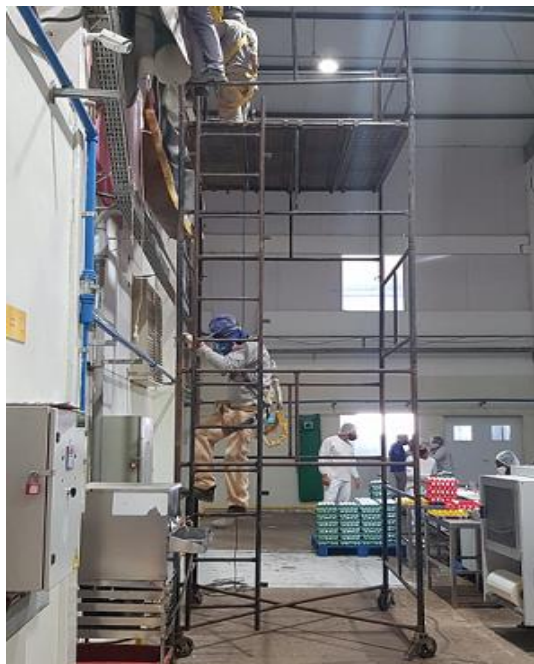
Figura 32 - Andaimos para o trabalho em altura em área de classificação de ovos.
